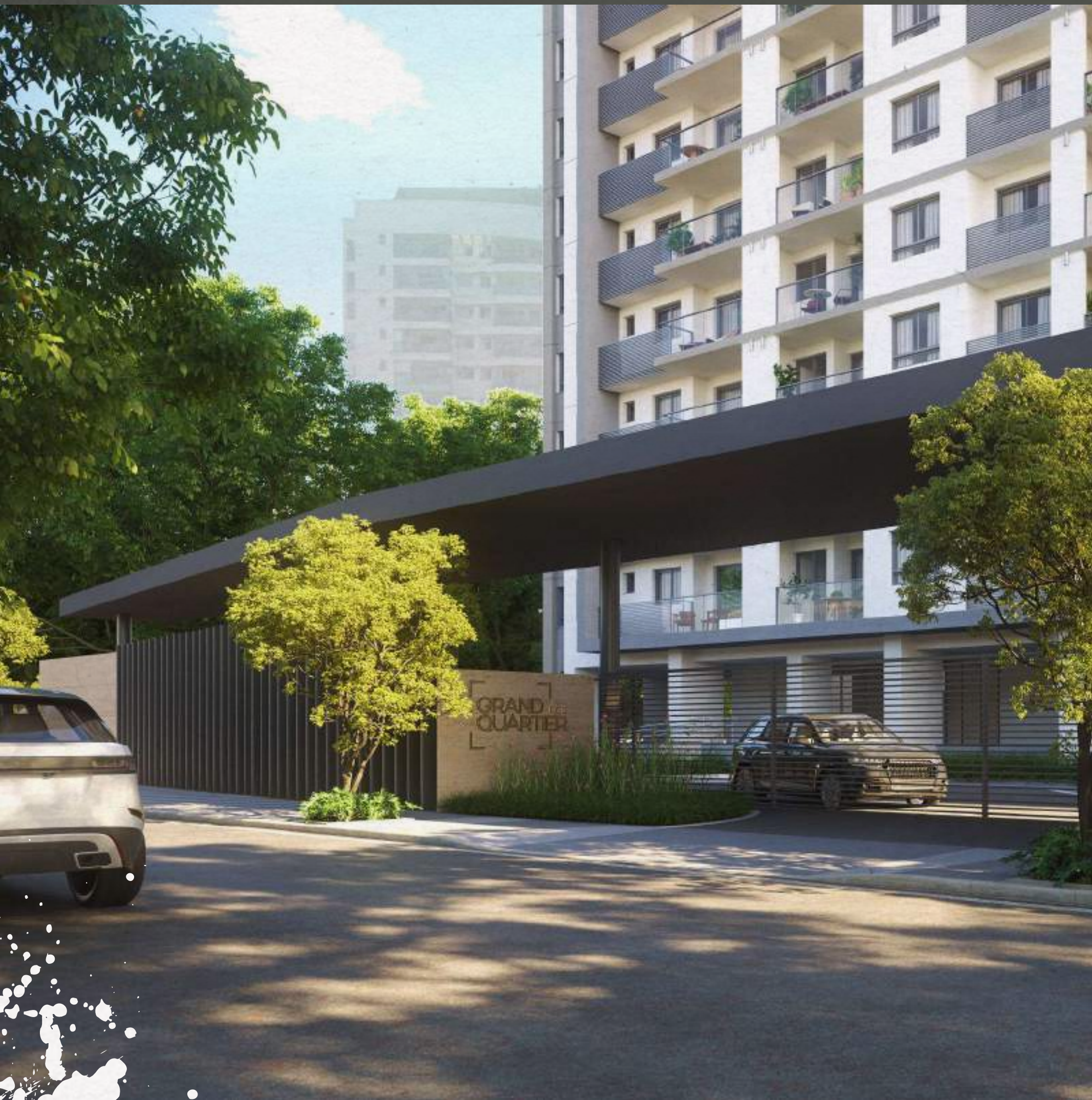
Pórtico de entrada Rua Franz Weissman
