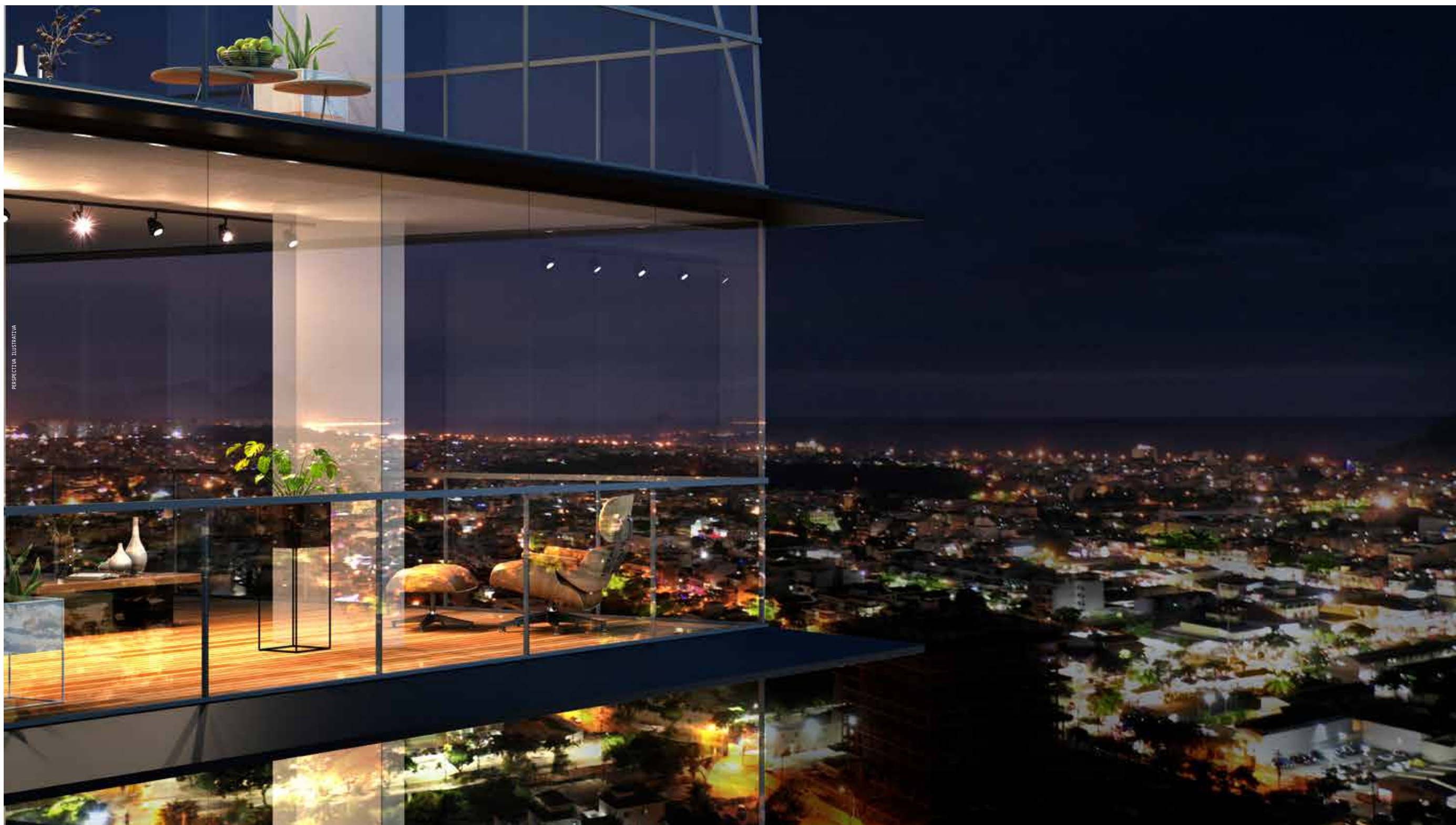
VISTA DETALHE DA FACHADA
