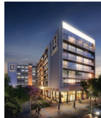
UpSide Araguaia Rua Araguaia, 1.763 Freguesia
